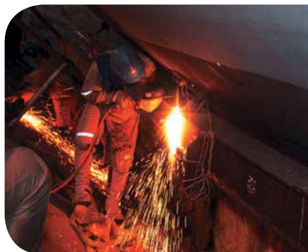
Remoção de suporte temporário durante a flutuação da contenção metálica
