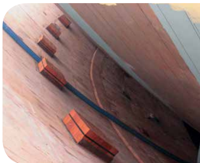
Calços de madeira para apoio da contenção na calota de concreto
