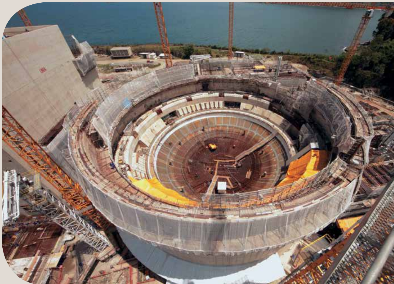
Estrutura tem como função impedir a liberação de radiação na eventualidade de um acidente
