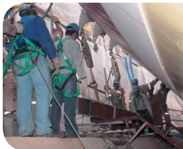
Desmontagem de suporte temporário durante a flutuação
