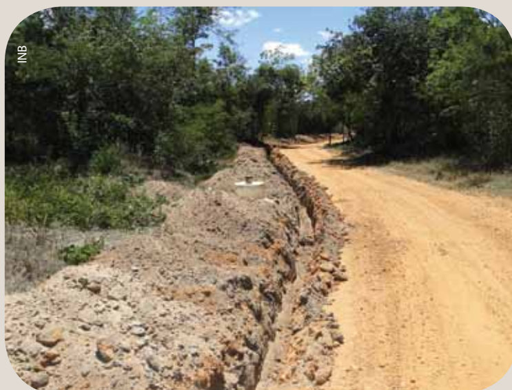
Cerca de cinco mil pessoas estão sendo beneficiadas pela Adutora de Maniaçu, inaugurada após a implantação de 15 quilômetros de tubulação para levar a água de um reservatório da INB até o distrito
